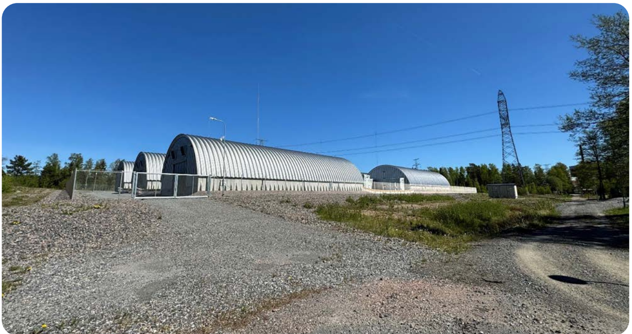
Kuva 9. Nykyinen alueella oleva akkuenergiavarasto.
